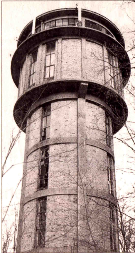
Der seit Jahren leer stehende und dem Verfall preisgegebene Wasserturm ist Teil des Projektes. Er soll eine öffentlich zugängliche Aussichtsplattform erhalten. Foto GMD/It
